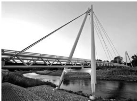
Fußgängerbrücke in Gera | Ingenieurbüro Kleb, Erfurt
