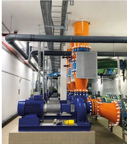
Zwischenpumpen im Keller der Aufbereitung.
