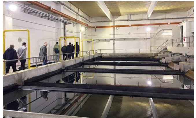
Die Aufbereitung des Wassers erfolgt in mehreren Zwischenschritten, hier zu sehen: Aktivkohlefiltration des Wassers.
