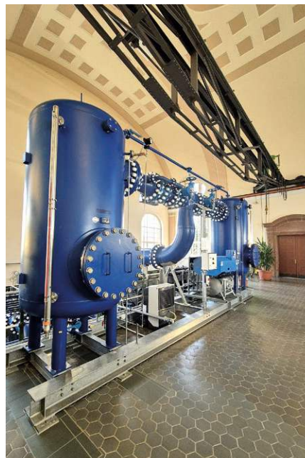
Druckstoßkessel im alten Pumpwerk.
