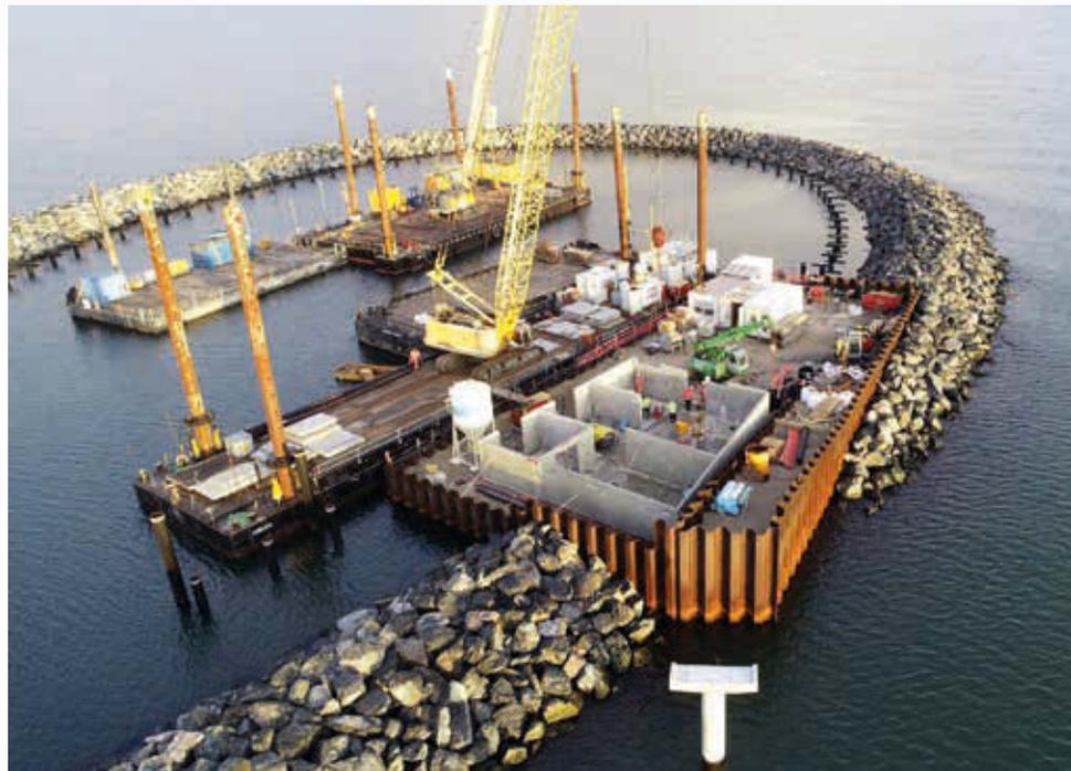
Das Hafengebäude wurde auf einen verfüllten Spundwandkasten mittels Stahlbetonfertigteilen gebaut. Fertigteile und Wellenbrecher konnten nur seeseitig transportiert werden. Foto: Land M-V
