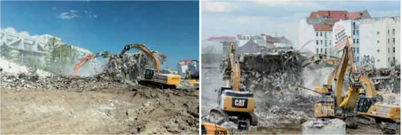
Der enorme Maschineneinsatz sorgt für eine hohe Staubemission. Wasserdüsen an den Abbruchwerkzeugen helfen den Staub zu binden.
