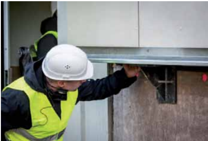
Befestigte Wandelemente auf der Konsole
