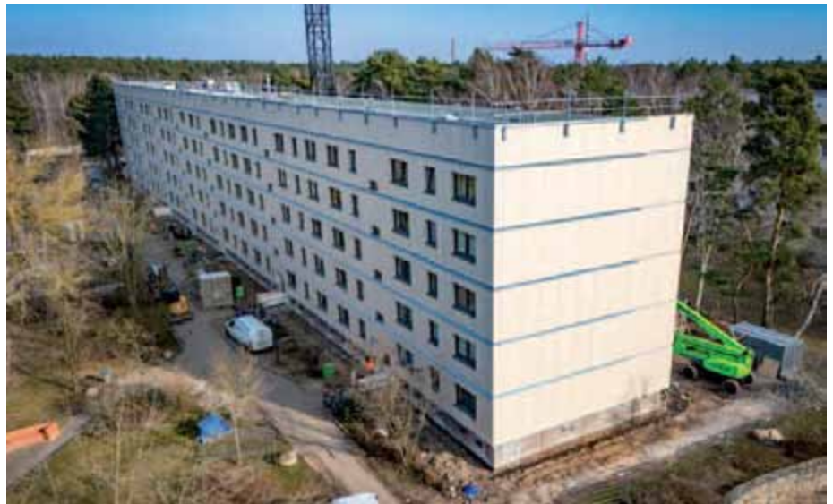
Alter Plattenbau mit neue energetischer Gebäudehülle
