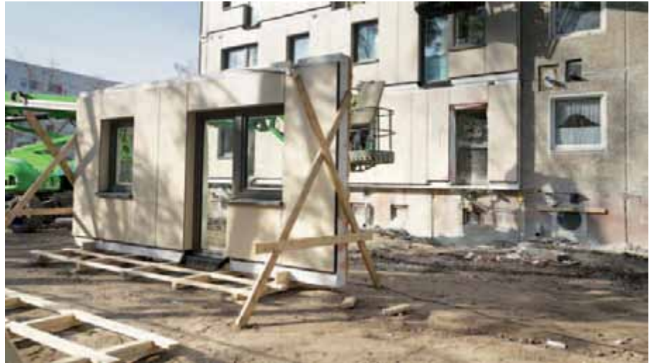
Holzrahmenmodule mit integrierten dreifach verglasten Fenstern, einer Wärmedämmung und einer Oberfläche aus Faserzement. Foto: Bärbel Rechenbach
