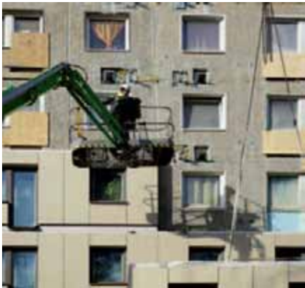
Die ersten Elemente auf der Loggiaseite sind montiert.
