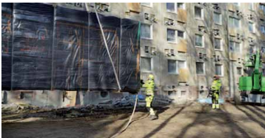
Die 1.000 kg schweren vorgefertigten Fassadentafeln wurden „just in time“ aus Tallin auf die Ludwigsfelder Baustelle geliefert.
