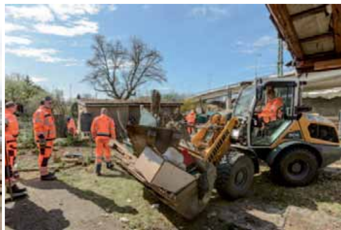
Holzbohlen, Stahlbleche, Vliesbahnen, Recycling und Sand schützten die Gleise während des Abrisses und mussten nach dem Ende der Arbeiten wieder zurückgebaut werden. Rechts: Dem Brückenabriss mussten auch einige Kleingartenparzellen weichen.
