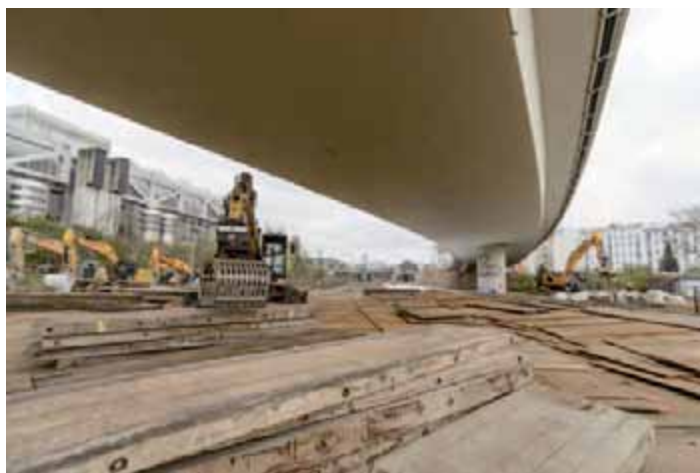
Holzbohlen, Stahlbleche, Vliesbahnen, Recycling und Sand schützten die Gleise während des Abrisses und mussten nach dem Ende der Arbeiten wieder zurückgebaut werden. Rechts: Dem Brückenabriss mussten auch einige Kleingartenparzellen weichen.
