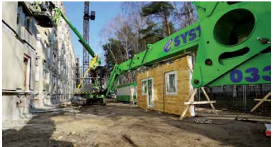
Die 1 000 Kilogramm schweren vorgefertigten Fassadentafeln wurden Just-in Time aus Tallin auf die Ludwigsfelder Baustelle geliefert. Foto: Bärbel Rechenbach
