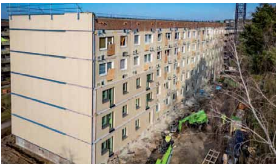
Die Fassade ist für das Befestigen der neuen Elemente vorbereitet.
