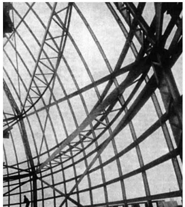
Bild 4 Kuppelkonstruktion des Berliner Doms im Bauzustand
