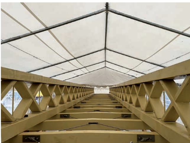
Werkmontage der Holzbrücke in der Firma Bennert im thüringischen Klettbach.
