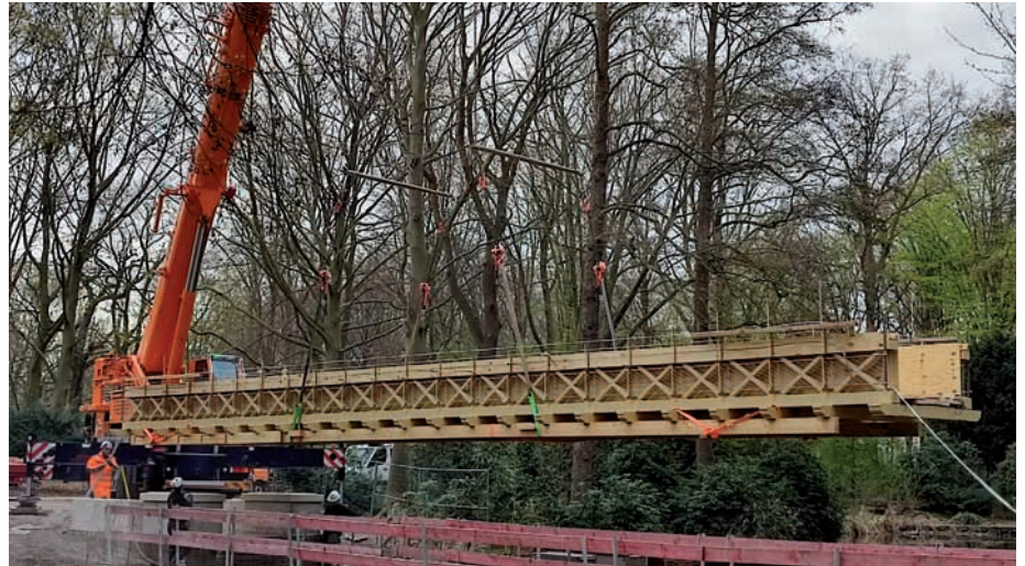
Einbau der neuen Holzbrücke im April 2025.
