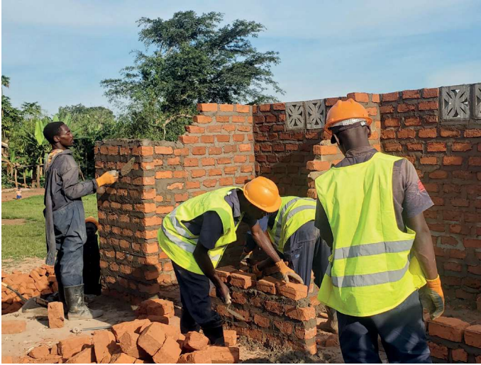
Errichtung der Schultoiletten
