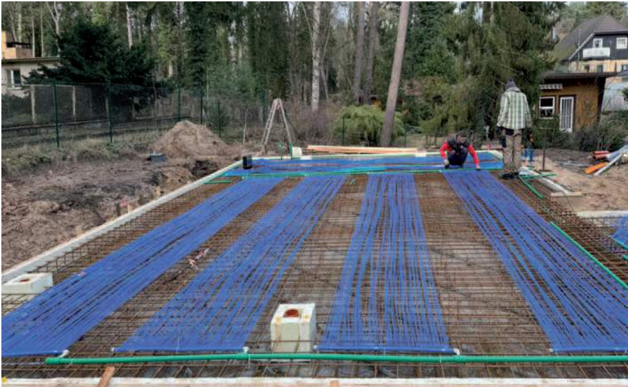
Installation des Kapillarrohrsystems
