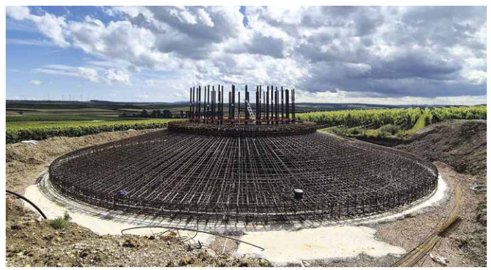
Das Stahlbetonfundament mit 24 m Durchmesser und einem Volumen von 850 m 3 bei einer Höhe von 2,8 m, hergestellt aus Ortbeton der Güteklassen C40/50 und C30/37.
