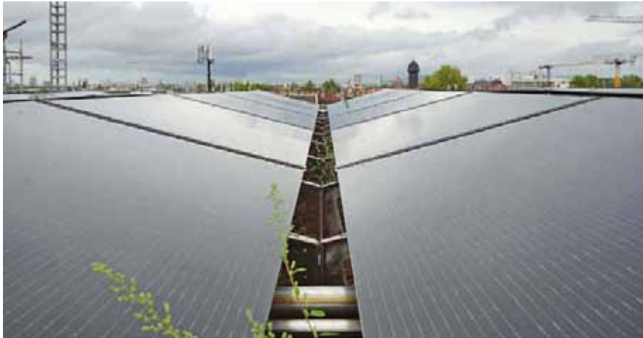
Die Anlage vereint Photovoltaik- und Solarthermiemodule (PVT) auf dem Dach des Dockyard und ist aktuell die größte Deutschlands. Foto: Bärbel Rechenbach
