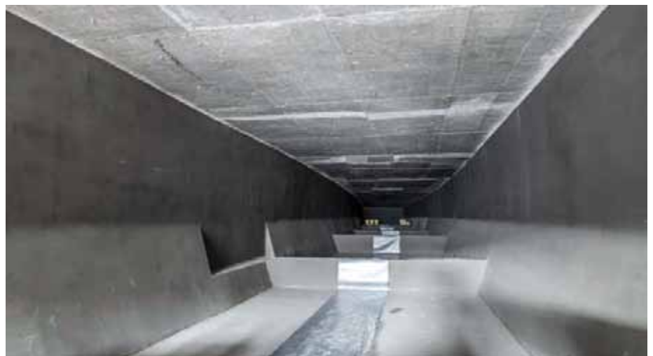
Der Eisspeicher mit 1.500 m 3 Fassungsvermögen als Saisonspeicher.
