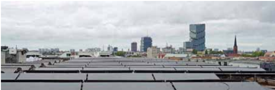
Die Anlage vereint Photovoltaik- und Solarthermiemodule (PVT) auf dem Dach des Dockyard und ist aktuell die größte Deutschlands. Foto: Bärbel Rechenbach
