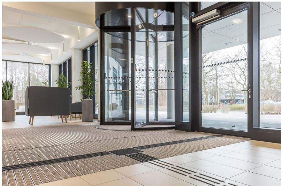
Fexibel auslegbare Sauberlaufmatten mit taktilen Bodeninformationen erfüllen die Anforderungen nach DIN 32984. Foto: © emco Bau
