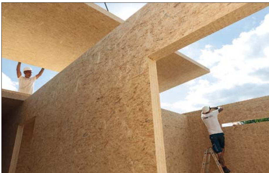
Schneller Baufortschritt durch großformatige, vorgefertigte Wand- und Deckenelemente. (Bildnachweis: © SWISS KRONO | Foto: Andrea Kroth)
