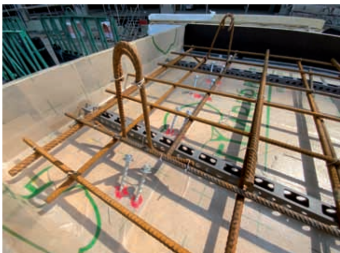
Abbildung 3: Montierte Verbundschrauben und Bewehrung
