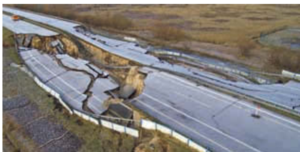
Abb. 1: Versagen des Verkehrsdammes der BAB A 20 bei Tribsees (NDR 1 Niedersachsen. 2022)
