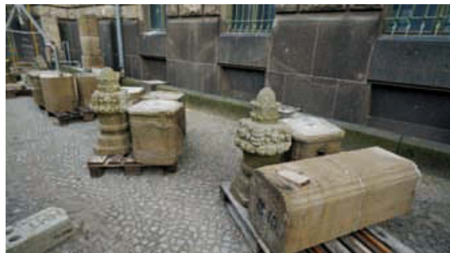
Demontierte Fassadenelemente werden für die Wiederverwendung sorgfältig gelagert
