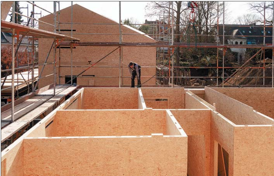
Außen- und Innenwände und auch das Dach bestehen aus SWISS KRONO MAGNUMBOARD® OSB. (Bildnachweis: © SWISS KRONO | Foto: Dirk Bleicker)
