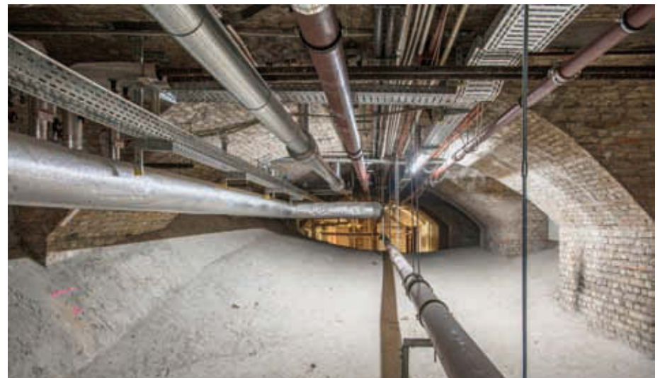
Bild 12 Pergamonmuseum Berlin, Oberseite der Kolkbrücke, Aufnahme 2022
