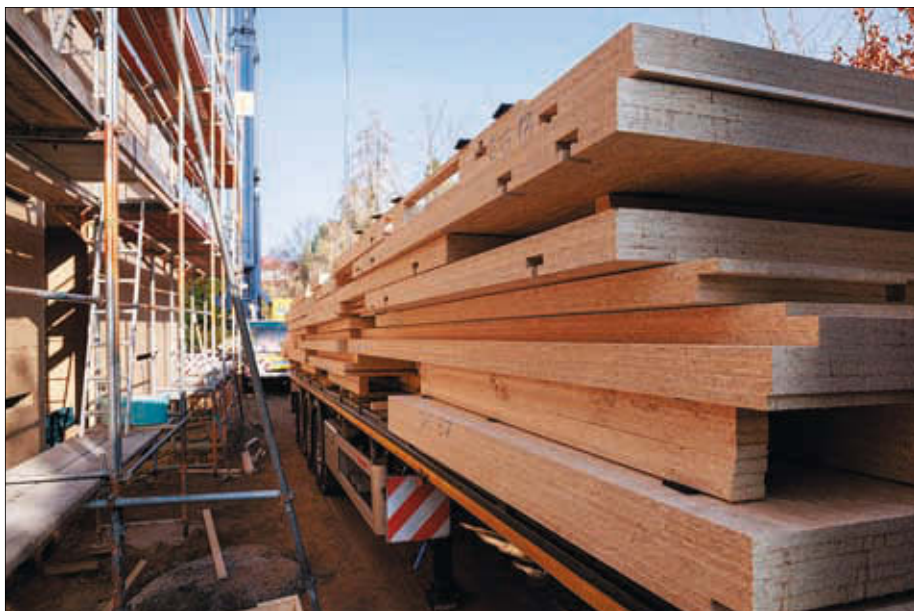
Anlieferung der Elemente, die in der Reihenfolge der Montage auf den Sattelschlepper geladen wurden. (Bildnachweis: © SWISS KRONO | Foto: Dirk Bleicker)
