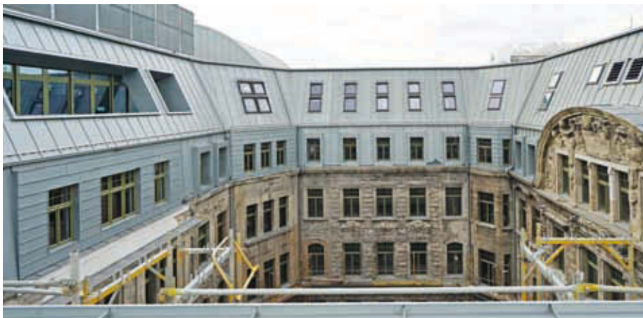
Aufstockung mit einem 5. Obergeschoss und Dachterrasse
