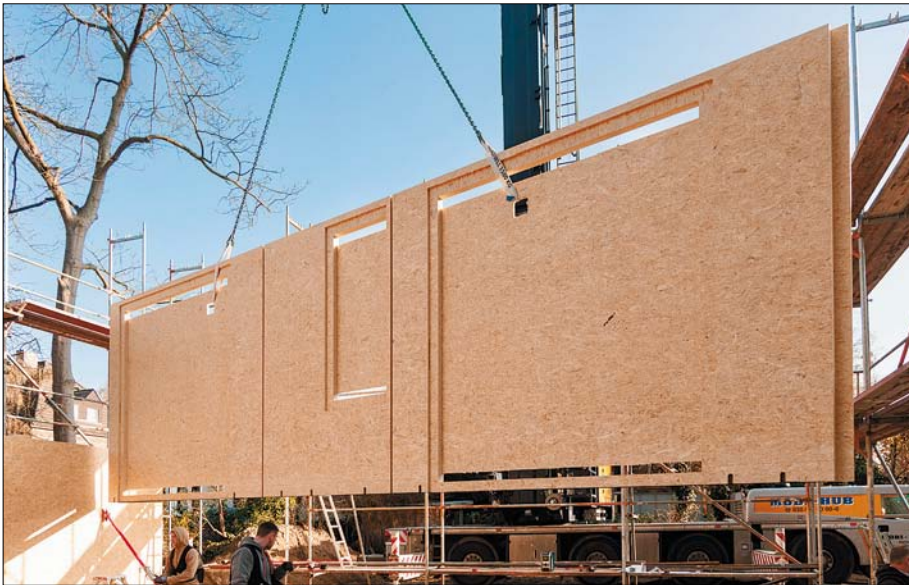
Vom LKW werden die großformatigen Elemente mit einem Kran direkt an die Position ihrer Montage transportiert (Bildnachweis: © SWISS KRONO | Foto: Dirk Bleicker)
