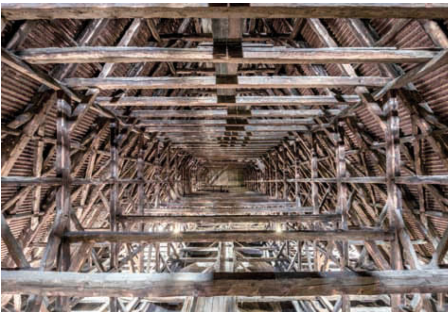
Bild 7 Marienkirche Berlin, Dachtragwerk (um 1520), Blick nach Ost im stehenden Stuhl, Aufnahme 2022
