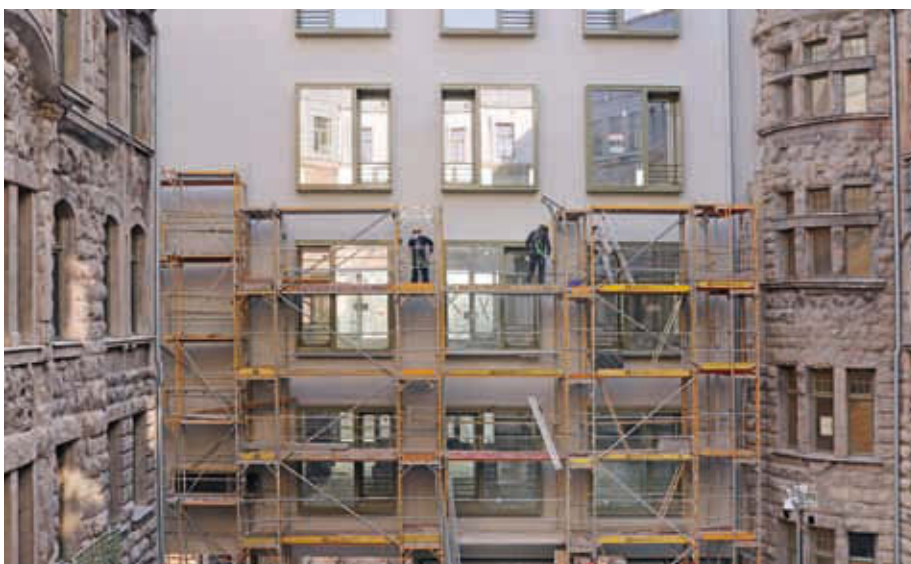
Fassadenarbeiten im Innenhof
