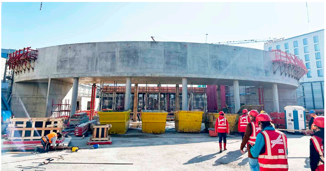
Der Rohbau des neuen Zugangsterminals steht. Auch in der Eingangssituation dominieren runde und ovale Formen.
