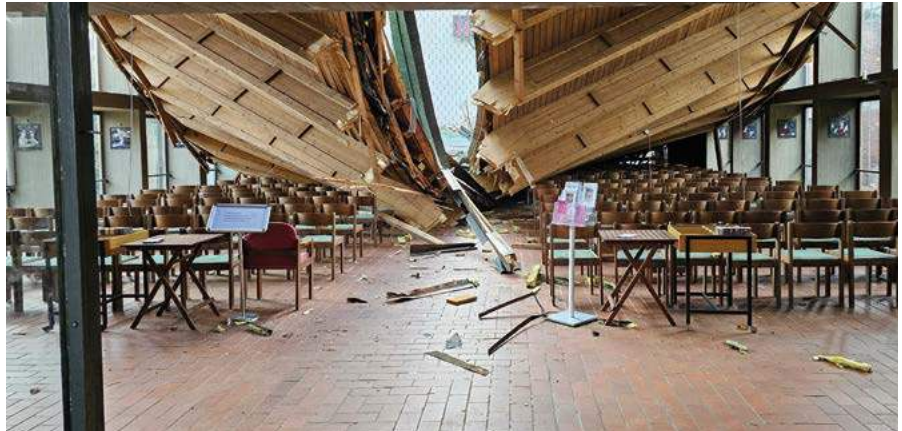
Eingestürztes Dach der Elisabethkirche Kassel, Foto: Feuerwehr Kassel
