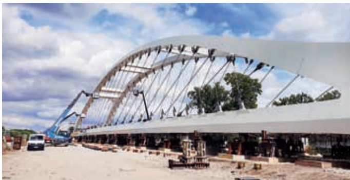
Blick auf die eingebauten Carbonhänger der Netzbogenbrücke (Juli 2023) [Quelle: DB Netz AG]
