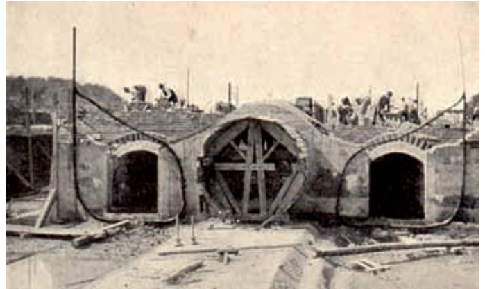
Trennungsfuge in der Mittelmauer
