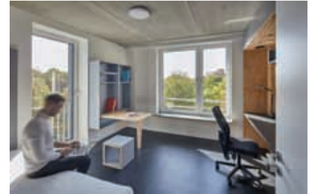
Blick in eine Wohnung mit dem sichtbaren Tragwerk aus Spannbeton-Fertigdecken und deckengleichen Verbundträgern in der Außenwand. Quelle: S. Steinprinz
