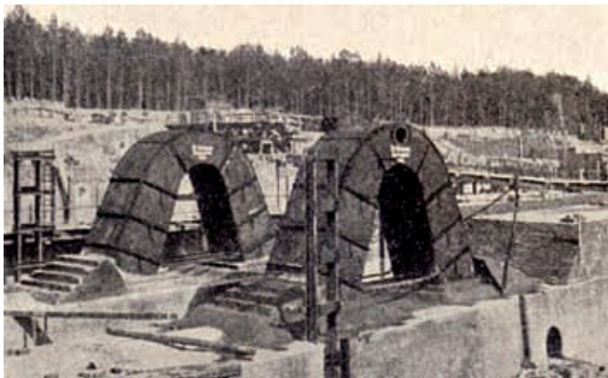
Unterhaupttheber der Mittelmauer
