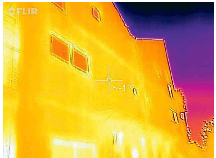
Abb. 2: Temperaturdifferenzen Mauerwerk/Beton am Nordgiebel
