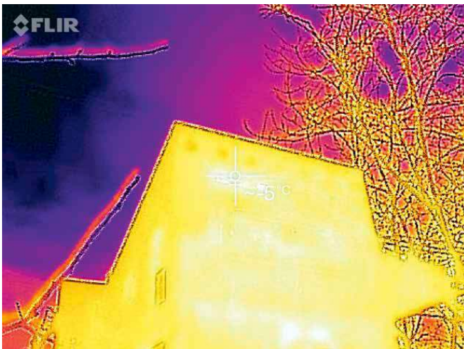
Abb. 5: Gartenseitige Westansicht des Mauerwerks des Nachbarhauses
