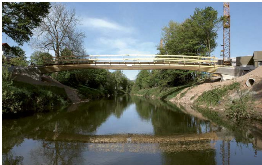
Beispielhaftes Ingenieurbauwerk aus Holz: die ‚Stuttgarter Holzbrücke‘ in Weinstadt-Birkelspitze nach dem Einhub im April 2019 (Tragwerksplanung: Knippers Helbig)
