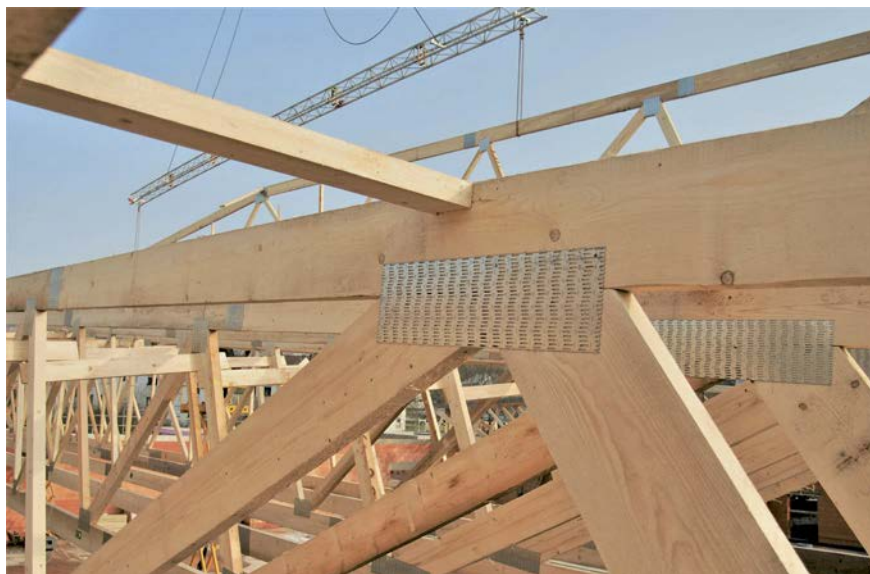
Holzkonstruktionen in Nagelplattenbauweise sollten nach Ansicht der Fachkommission Bautechnik der Bauministerkonferenz dringend überprüft werden.
