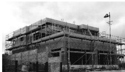
Bautenstand November 2013 (Foto: Bauherrschaft).
