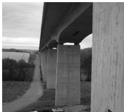
Scherkondetalbrücke: Seitenansicht der Konstruktion
