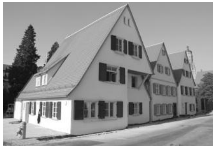
Foto: ALS Ingenieure / Glash.Lamberts
