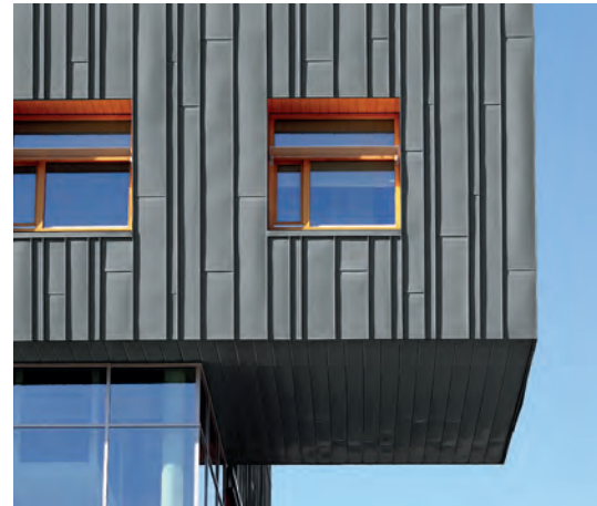
Auf der Unterseite kamen Steckfalzpaneele zum Einsatz, an den Fassaden die Winkelstehfalztechnik.
