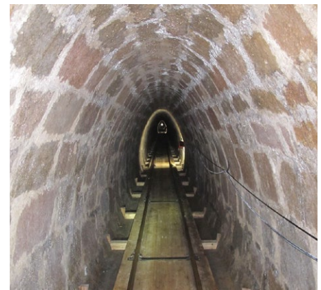
Altbergbauliche Anlagen müssen in heutigen Planungen weiter berücksichtigt werden.
