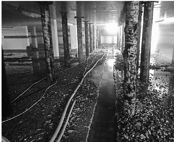
Herkömmliche Instandsetzung einer Tiefgaragenbodenplatte mit Betonabtrag durch Höchstdruckwasserstrahlen (Bild: Prof. Dauberschmidt)
