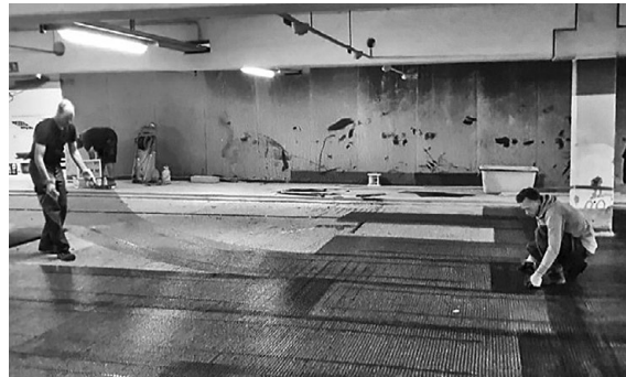
Verstärkungsmaßnahme in einer Tiefgarage mit textilen Carbongelegen (Bild: Prof. Dauberschmidt)
