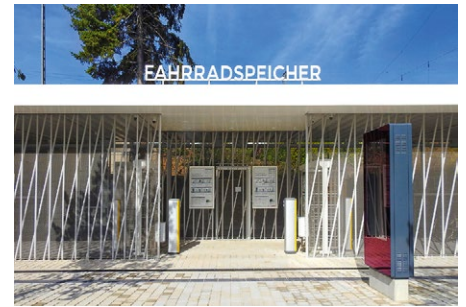
Fahrradspeicher – Nürnberg TRAGRAUM Ingenieure PartmbB
