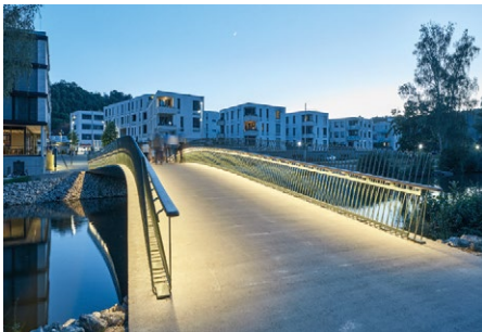
Herzogsteg – Eichstätt Bergmeister Ingenieure GmbH
