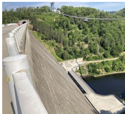
Blick auf die Staumauer
