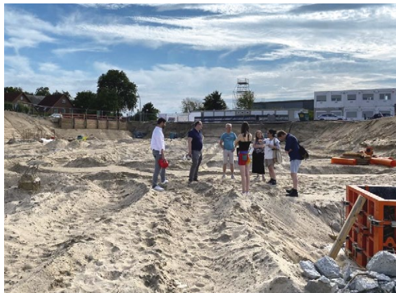
Und immer lockt die Baustelle: Georg Feldmann (WP Ingenieure) und Daniel Schmitz-Mohr (pbp architekten bda) erläutern gemeinsam die Gründung des ElbAir Dienstleistungszentrum Airbus
