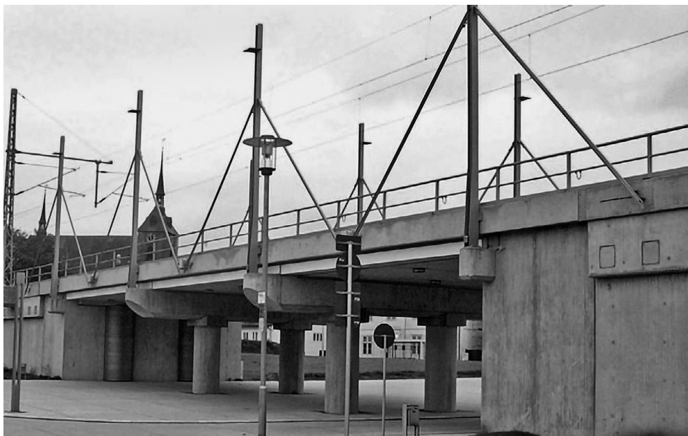
Massive Betonkubaturen bei Widerlager in konventioneller Bauweise | Bild: Ingenieurbüro Mohn GmbH
