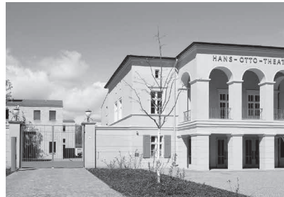
Wissenschafts- und Restaurierungszentrum Potsdam © Staab Architekten
