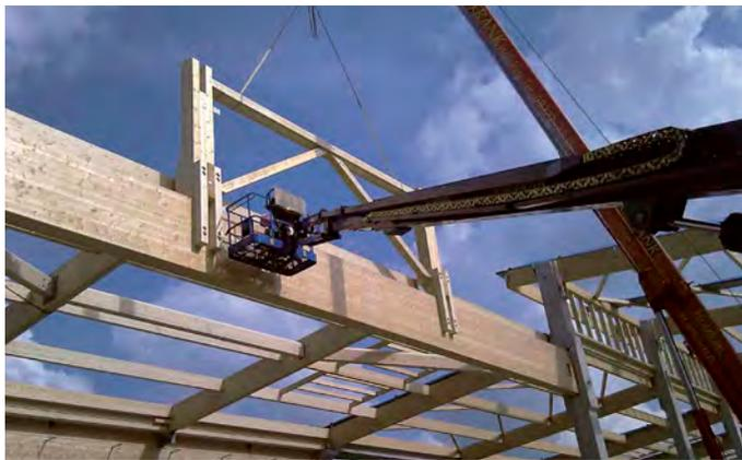
2 Spezielle Vertikalverbände mit Diagonalverstrebrungen setzen in den Shed-Achsen als Auflager für die Dachbinder auf den Längsträgern auf.
