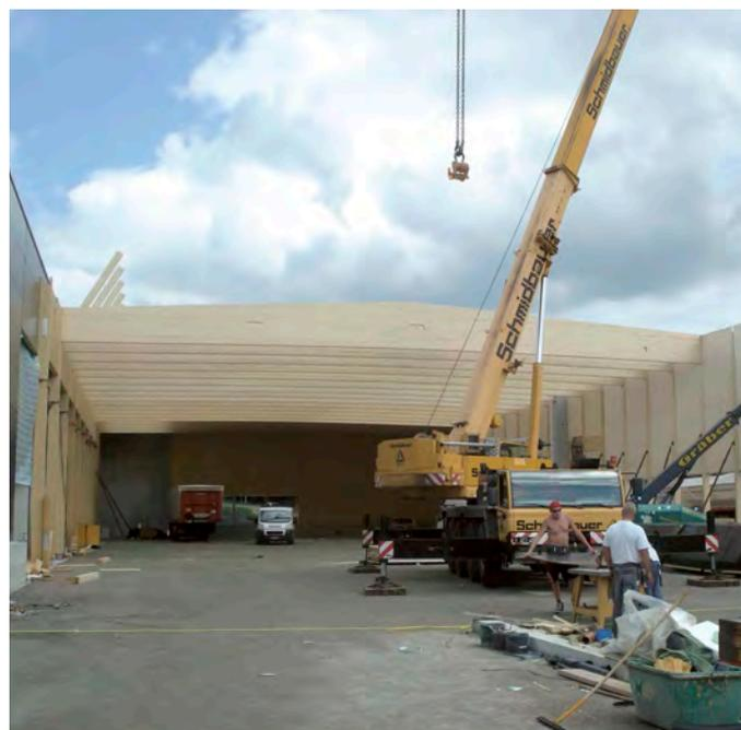
**1 Montage der Satteldachbinder:** Die Wandelemente sind zwischen den Pendelstützen eingefügt und ragen bis zur Binderoberkante über sie hinaus. So ergeben sich gabellagerähnliche Taschen, in die die Binderenden eingelegt werden und seitlich gehalten sind.
