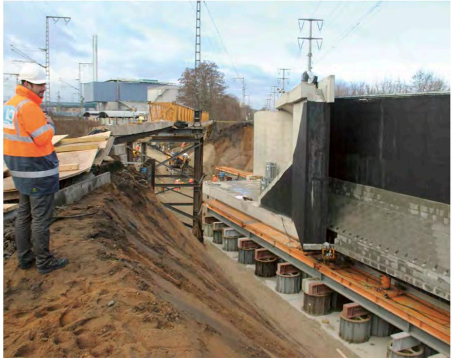
7 Im tieferen Teil der Baugrube unterfütterten Stapel die Vershubbahnen und glichen so den Höhenunterschied aus.
