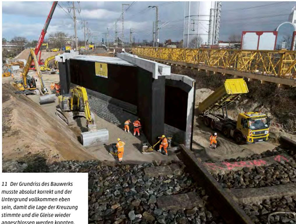
11 Der Grundriss des Bauwerks musste absolut korrekt und der Untergrund vollkommen eben sein, damit die Lage der Kreuzung stimmte und die Gleise wieder angeschlossen werden konnten.
