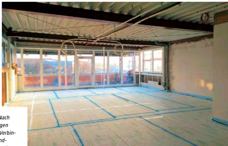
Abb. 2 und 3: Nach dem vollflächigen Auslegen und Verbinden der Verbundplatten werden die Rohrleitungen gemäß der vorher erstellten Berechnung verlegt. Bei diesem System sind das Klettband und die Haftfolie aufeinander abgestimmt.
