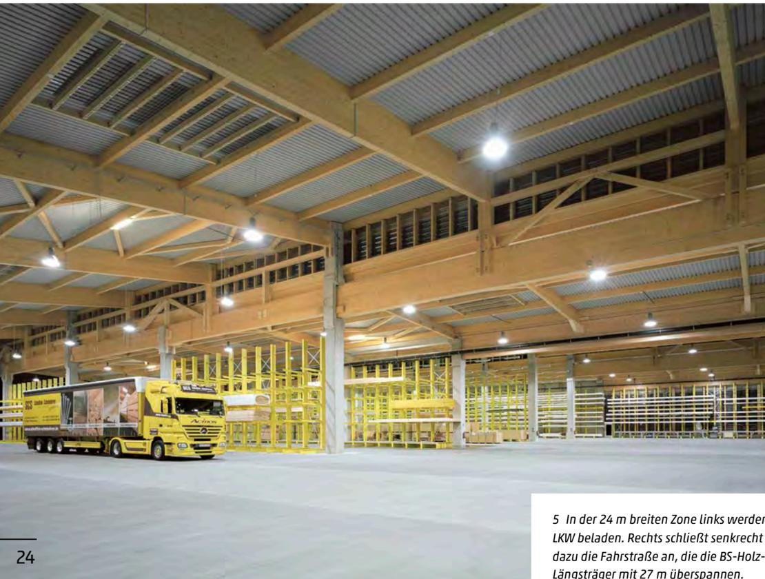
5 In der 24 m breiten Zone links werden LKW beladen. Rechts schließt senkrecht dazu die Fahrstraße an, die die BS-Holz-Längsträger mit 27 m überspannen.
