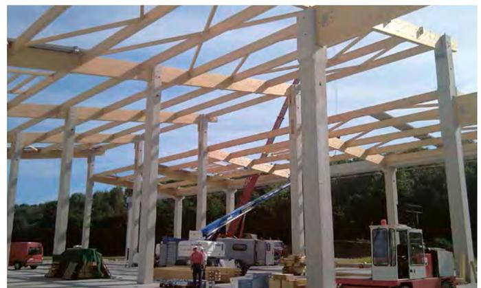
4 Montage der Dachbinder, Querträger und K-Verbände über einem der Lagerbereiche
