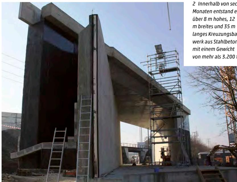
2 Innerhalb von sechs Monaten entstand ein über 8 m hohes, 12 m breites und 35 m langes Kreuzungsbauwerk aus Stahlbeton mit einem Gewicht von mehr als 3.200 t.
