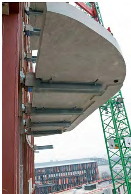
Für die Montage der Balkone konnten die freigelegten, durchgehenden senkrechten Stahlträger des tragenden Stahlskeletts genutzt werden.
