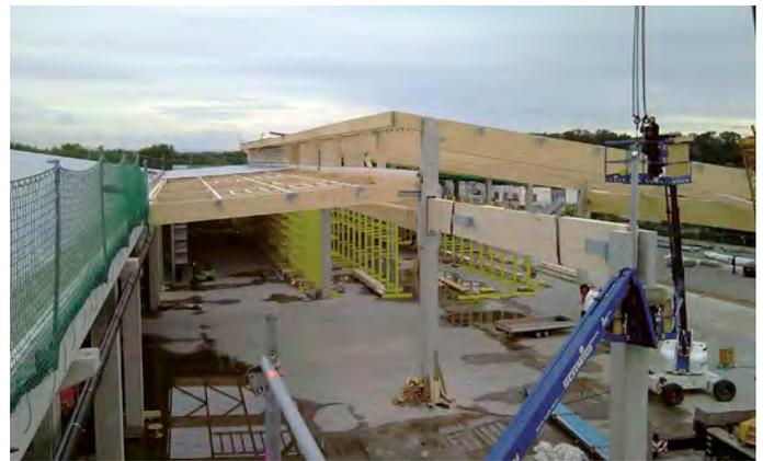
3 Stahlbeton-Stützen mit „Nadelöhr“ und Gabellager am Stützenkopf nehmen die Längsträger ebenso auf wie die Dachbinder.
