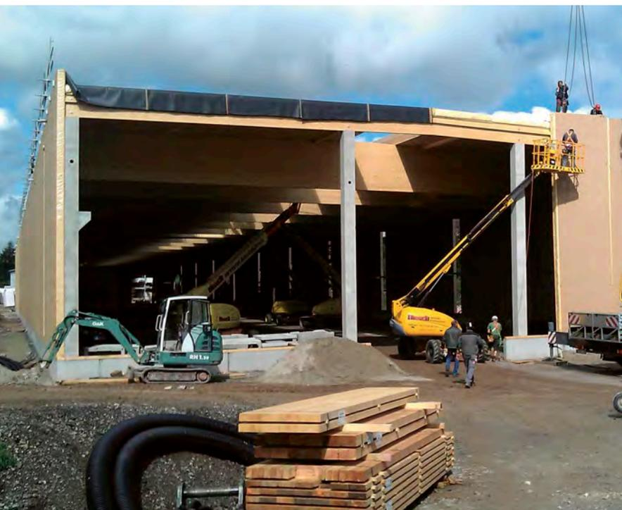
Um auch den mineralischen Teil der Halle zügig voranzubringen, wurden die 46 Stahlbetonstützen (b/d = 45 cm x 40 cm) mit Einzelfundamenten als Komplettfertigteile per Schwertransport auf die Baustelle geliefert und ver-setzt.
