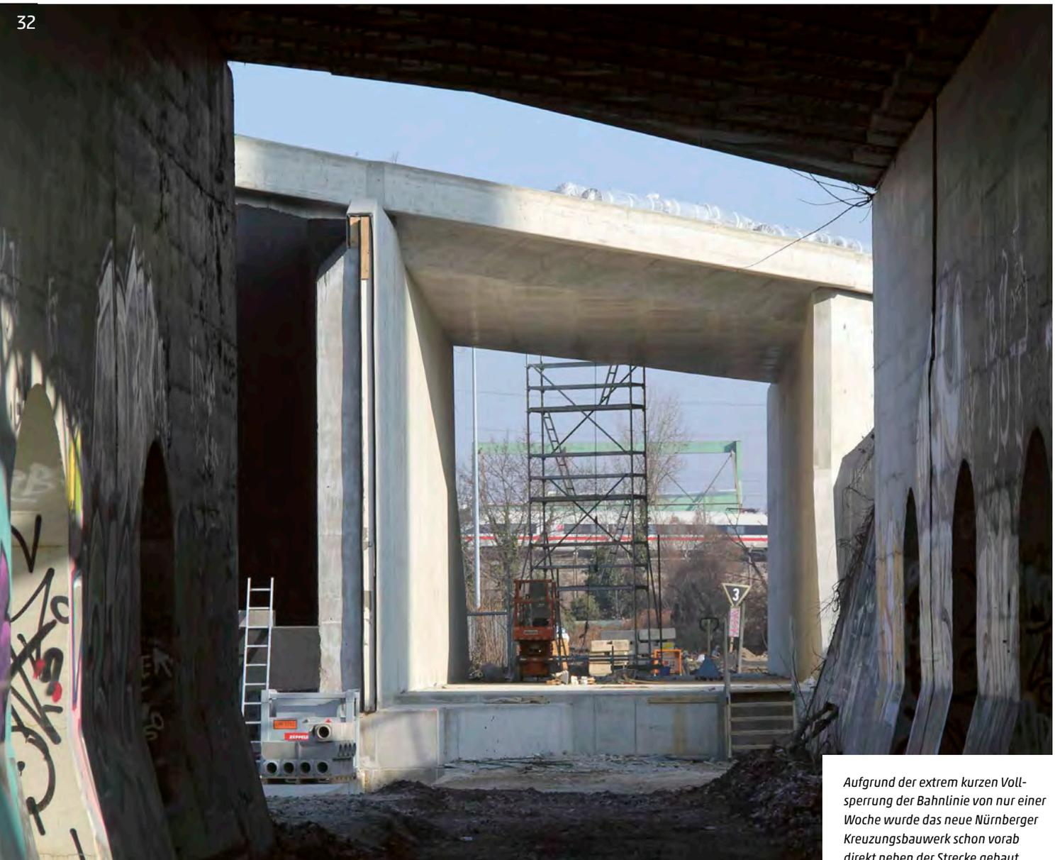
*Aufgrund der extrem kurzen Vollsperrung der Bahnlinie von nur einer Woche wurde das neue Nürnberger Kreuzungsbauwerk schon vorab direkt neben der Strecke gebaut.*
