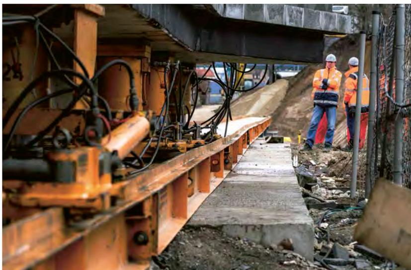
5 Je Seite setzten die Mitarbeiter acht Pressen mit einer jeweiligen Traglast von 250 t unter das Bauwerk und verschraubten sie. Unter die Pressen wurde Stickstoff mit einem Druck von 26 bar geleitet, sodass das Bauwerk wie auf einem Luftpolster in seinen Fahrinnen gleiten konnte.
