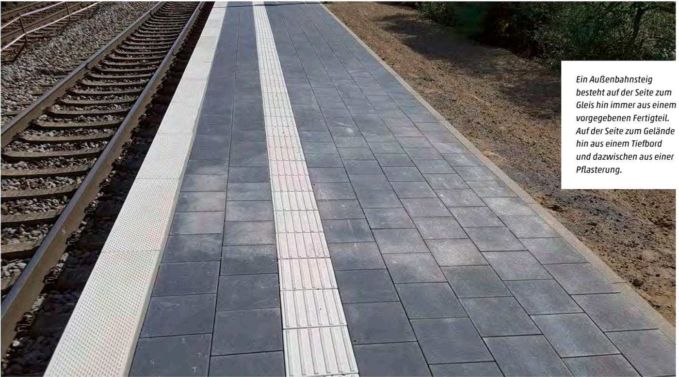
Ein Außenbahnsteig besteht auf der Seite zum Gleis hin immer aus einem vorgegebenen Fertigteil. Auf der Seite zum Gelände hin aus einem Tiefbord und dazwischen aus einer Pflasterung.
