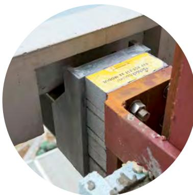
Der „Schöck Isokorb Typ KST“ sorgt für die thermische Entkopplung.
