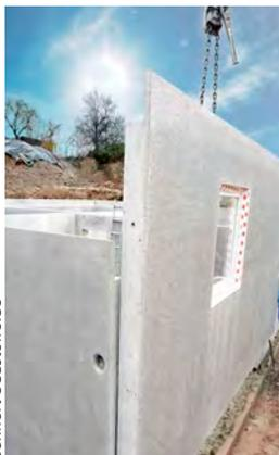
Die massiven Wandelemente werden im Werk exakt nach den individuellen Bauplänen vorgefertigt.
