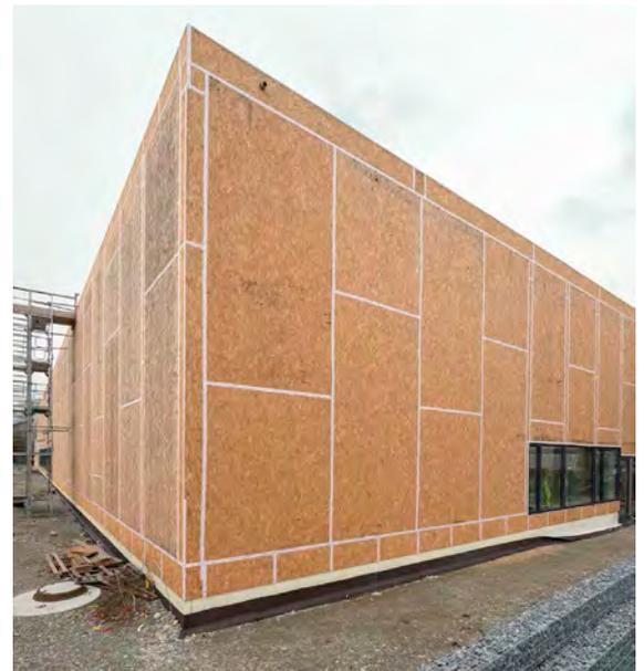
5 Alle Wandelemente wirken aussteifend zwischen den Pendelstützen. Für die Gebäudeaussteifung sorgen aber vor allem die hallenhohen, geschlossenen Wandscheiben. Außenseitig verbinden OSB-Platten die Elemente stützenübergreifend zu größeren Wandscheiben.
