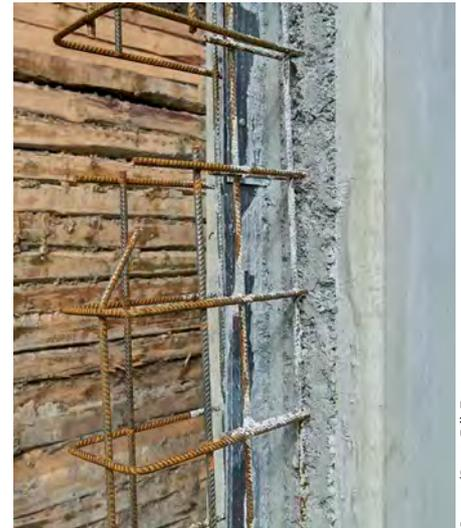
Übergang zu einem bereits betonierten Wandbauteil mit Fugendichtband
