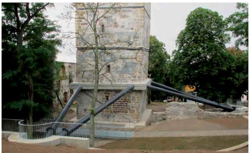
Ansicht Sicherungskonstruktion mit Steg zur Schwedengasse
