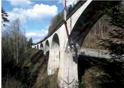
Von einer mobilen Arbeitsbühne unterhalb des Laufenmühle-Viadukts wurden detaillierte Zustandsaufnahmen per Radar und Ultraschall durchgeführt.
