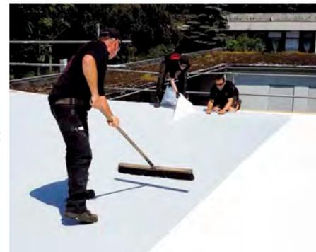
Vollflächig verkleben ohne offene Flamme: die Dach- und Dichtungsbahn „Tectofin SK“
