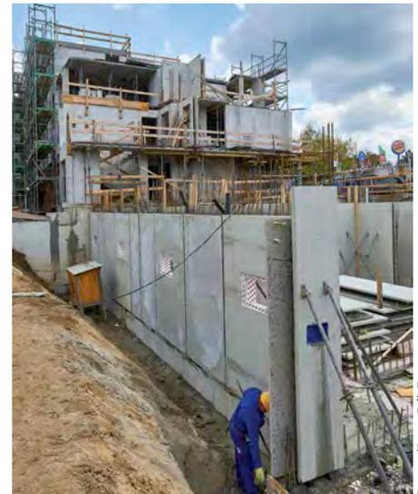
Bevor die Wandelemente fixiert werden, müssen sie genau ausgerichtet werden.
