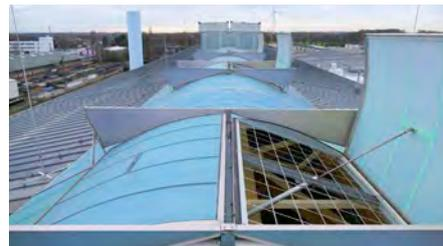
Das „Grillodur“-System verfügt über eine hohe mechanische Belastbarkeit und gilt als permanent durchsturzicher. Bei geöffneten RWA- oder Lüftungsklappen kann die Durchsturzicherheit mithilfe der Auffangeinrichtung „Grillodur DSG“ hergestellt werden.
