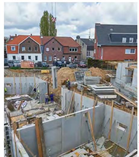
Die Doppelwandelemente werden mithilfe eines Krans versetzt.
