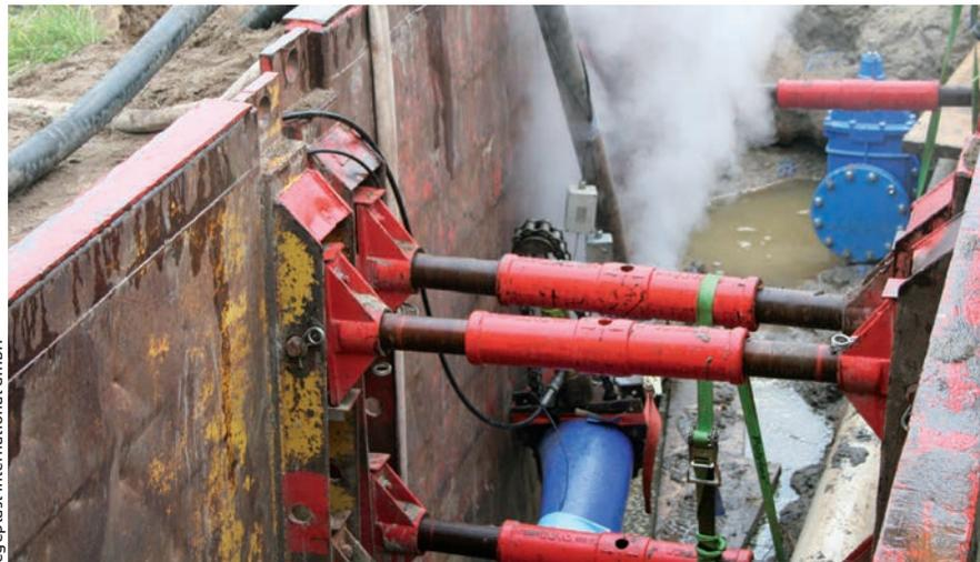
Über die mobile Dampfanlage wird Heißdampf mit einer Temperatur von ca. 120 °C erzeugt, der nach dem Einzug in den Close-Fit-Liner eingeleitet wird.
