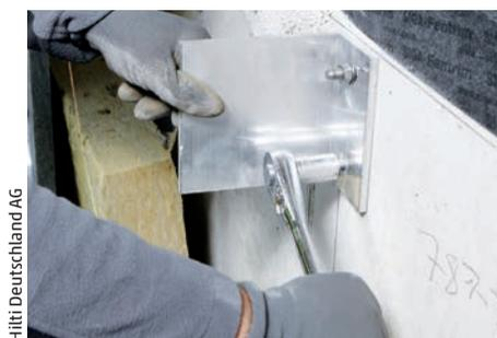
Fassaden können mit dem Hilti HST3 Bolzenanker näher am Rand befestigt werden, da die optimierte Beschichtung die Spreizkräfte über den gesamten Anker reduziert und minimale Rand- und Achsabstände erlaubt.
