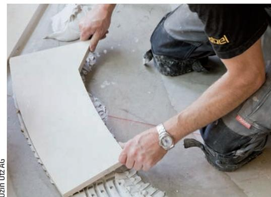
Ein wassergestrahlttes Element für die Kleeblattverlegung wird mit dem schnell härtenden, hoch kunststoffvergüteten weißen Dünnbettmörtel codex Stone SX 80 verlegt. Er entspricht der DIN EN 12004 C2 FTE sowie der Flexmörtelrichtlinie.
