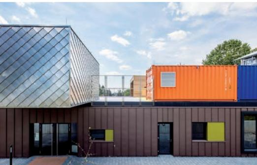
Nordostfassade mit Haupteingang des Erweiterungsbaus. Als Fassadenmaterialien entschied man sich für farbig beschichtetes Titanzinkblech, walzblankes Aluminiumblech und spezielle Fassadenplatten.
