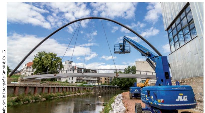
Montage Überbau mit temporärer Kranunterstützung bis zur Montage der Hänger
