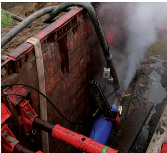
Durch den geringen Biegeradius des Close-Fit-Liners verringern sich die Größe der Baugruben und somit der Tiefbauaufwand und die damit verbundenen Kosten und Beeinträchtigungen erheblich.
