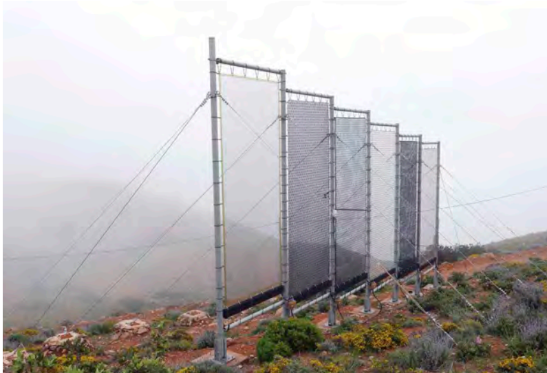
2 Textil stabil: Der faserbasierte Materialmix soll Windgeschwindigkeiten von bis zu 120 km/h standhalten – laut Wasserstiftung weltweit einmalig.
