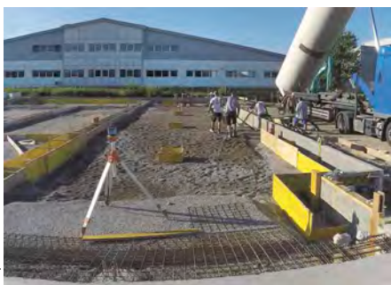
Rund 400 Kubikmeter Liapor Fundatherm bilden die Basis der neuen Halle in Grambach.
