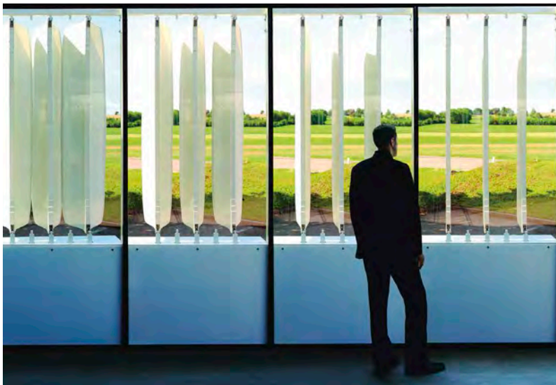
1 Durchblick verschaffen: Die Glasfasern in den flügelartigen Lamellen verhindern, dass das Material beim permanenten Wechsel zwischen auf und zu bricht.
