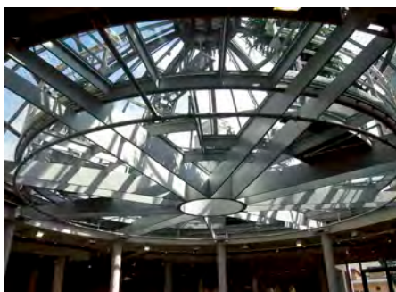
In der Globetrotter-Filiale in Stuttgart kamen zur Brandschutzbeschichtung der riesigen Stahl-Glas-Kuppel Produkte von Rudolf Hensel zum Einsatz.
