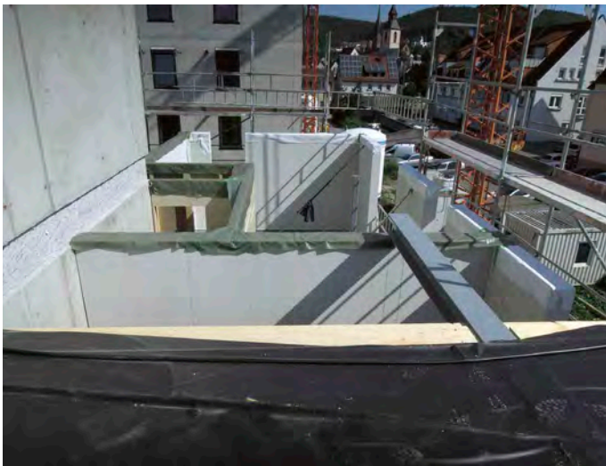
3 Beidseitig doppelt beplankte Holzrahmenbau-Wände dienen als Auflager für Stahlträger, die Lasten aus den Geschossen darüber aufzunehmen haben.
