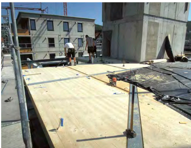
5 Diagonal verlegte Stahlträger nehmen die Lasten aus den über Eck auskragenden Decken auf.
