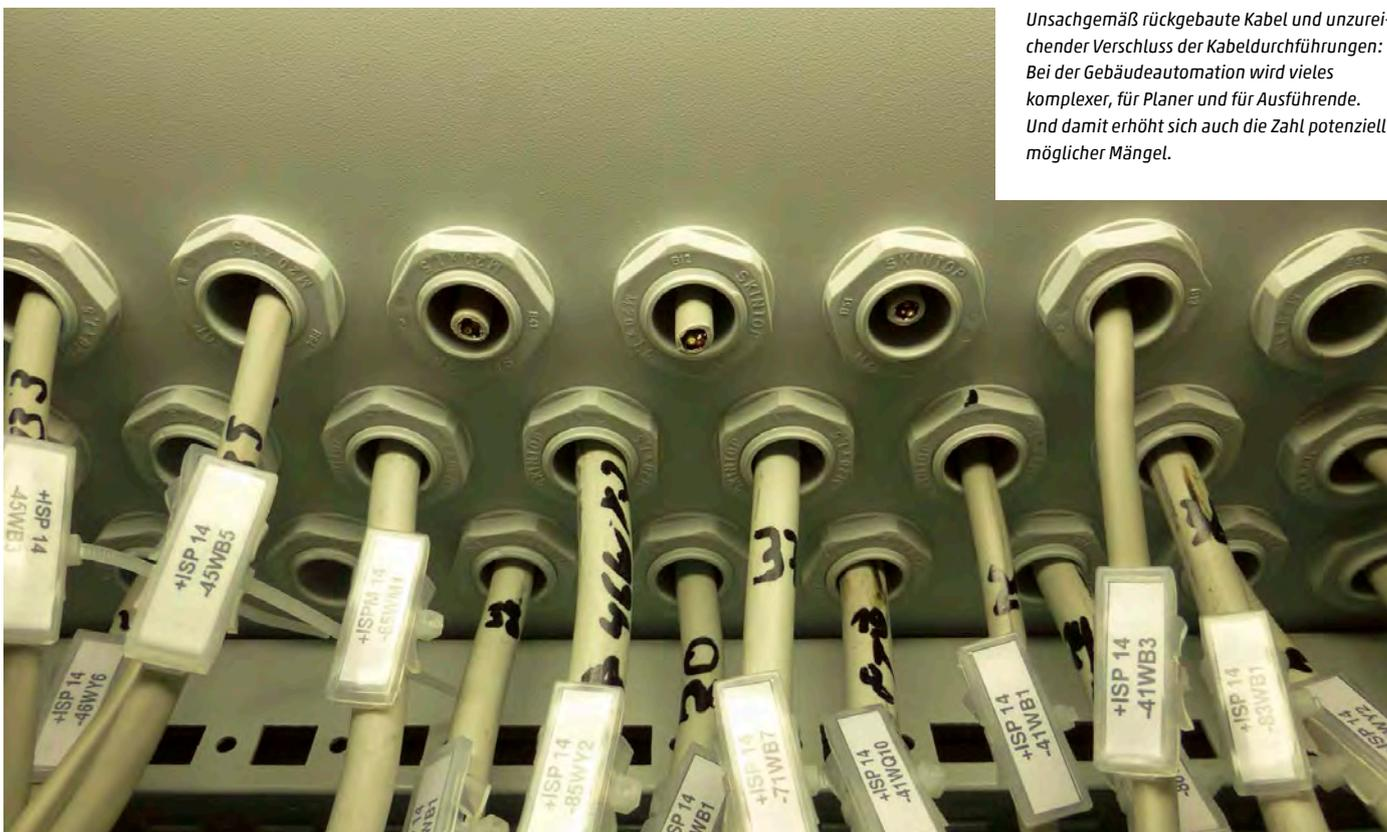
*Unsachgemäß rückgebaute Kabel und unzureichender Verschluss der Kabeldurchführungen: Bei der Gebäudeautomation wird vieles komplexer, für Planer und für Ausführende. Und damit erhöht sich auch die Zahl potenziell möglicher Mängel.*
