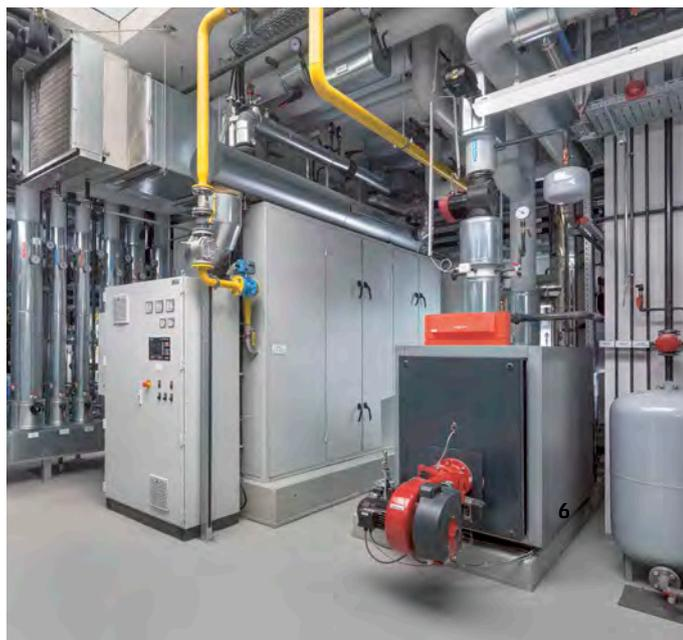
6 Ein Blockheizkraftwerk mit einer Leistung von 125 kW<sub>el</sub> und 184 kW<sub>th</sub> arbeitet nach dem Prinzip der Kraft-Wärme-Kopplung und stellt die benötigte Energie für verschiedene Prozesse im Unternehmen bereit.
