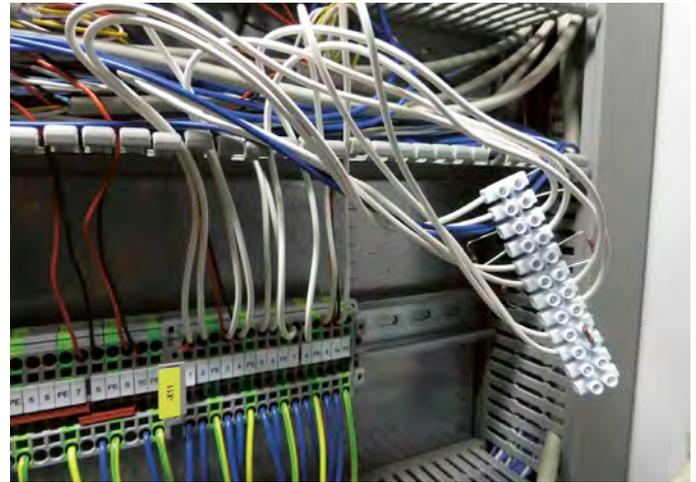
*Gefährlich: fahrlässige Überbrückung der Thermoüberwachungen elektrischer Antriebe.*
