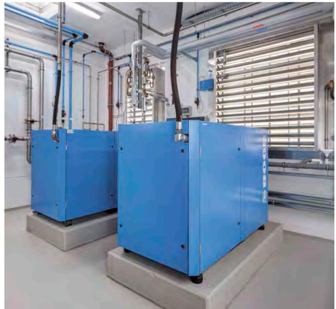
10 In der Druckluftzentrale wird die Abwärme der Kompressoren optimal zur Klimatisierung des neuen Produktions- und Verwaltungsgebäudes genutzt.
