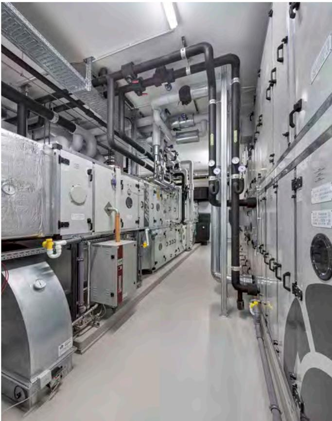
5 Die Steuerung der Raumlufttechnik erfolgt über die Luftzentrale. Da sowohl die Maschinenkühlung als auch die Hallenkühlung zentral erfolgt, kann das Blockheizkraftwerk, das Strom, Wärme und Kälte bereitstellt, sowohl im Sommer als auch im Winter effizient ausgenutzt werden.
