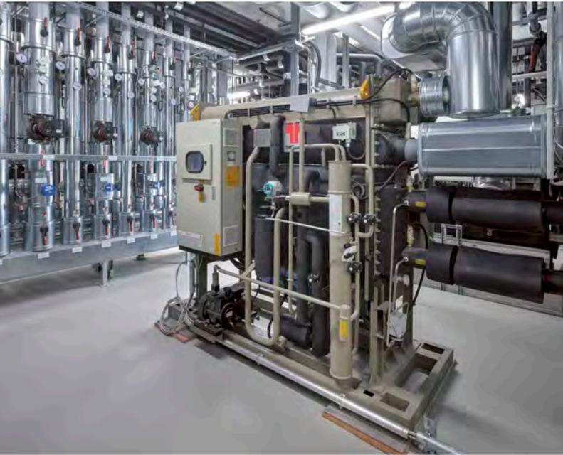
8 Um den Betrieb mit der erforderlichen Kälte zu versorgen, wurde eine Absorptionskältemaschine installiert.
