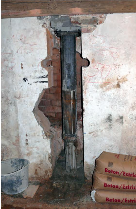
Abb. 8: eingebauter Mikropfahl
