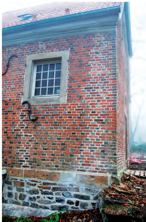
Abb. 7: sanierter Vertikalriss - Westwand
