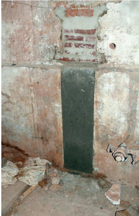
Abb. 9: vermauerter Mikropfahl
