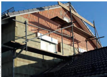
Die „Heck MW Fassadendämmung“ aus Steinwolle brennt nicht und trägt den Blauen Engel.
