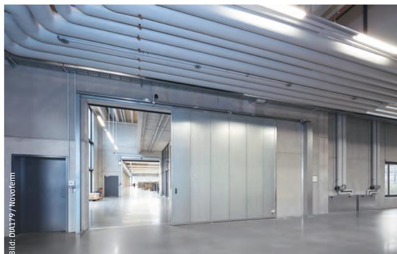
Abb. 3: Einflügeliges Feuerschutzschiebetor mit Feststellanlage und elektrischer Öffnungshilfe als großflächige Brandabschnitttrennung.
