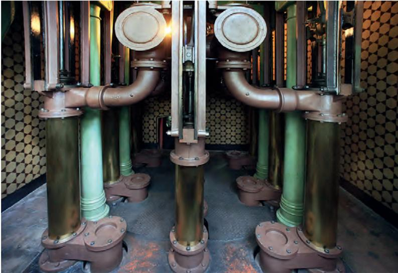
Die erhaltene Pumpenanlage in der östlichen Pumpenkammer. Nach Stilllegung der Maschine wurden die bronzenen Pumpenzylinder wegen ihres Materialwerts ausgebaut und später durch Nachbildungen ersetzt.
