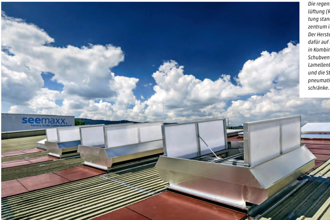
Die regensichere Brandlüftung (RWA) und Lüftung stand im Einkaufszentrum im Vordergrund. Der Hersteller Colt setzte dafür auf Haubenlüfter in Kombination mit Schubventilatoren, auf ein Lamellenlüftungssystem und die Steuerung über pneumatische Schalt-schranke.
