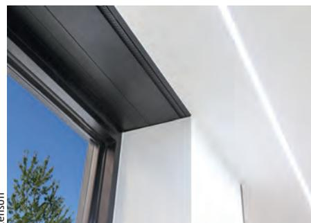
Über dem Fenster eingebautes Lüftungssystem „Endura Twist“ mit Luftaustritt nach unten.
