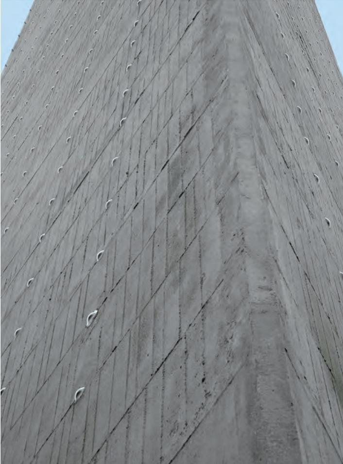
dass eine erneute Depassivierung ausgeschlossen werden kann. Auch bereits karbonatisierter Altbeton wird so wieder realkalisiert und bietet damit Schutz für den Bewehrungsstahl. Die Schichtdicke ist dabei abhängig von der Karbonatisierungstiefe.
