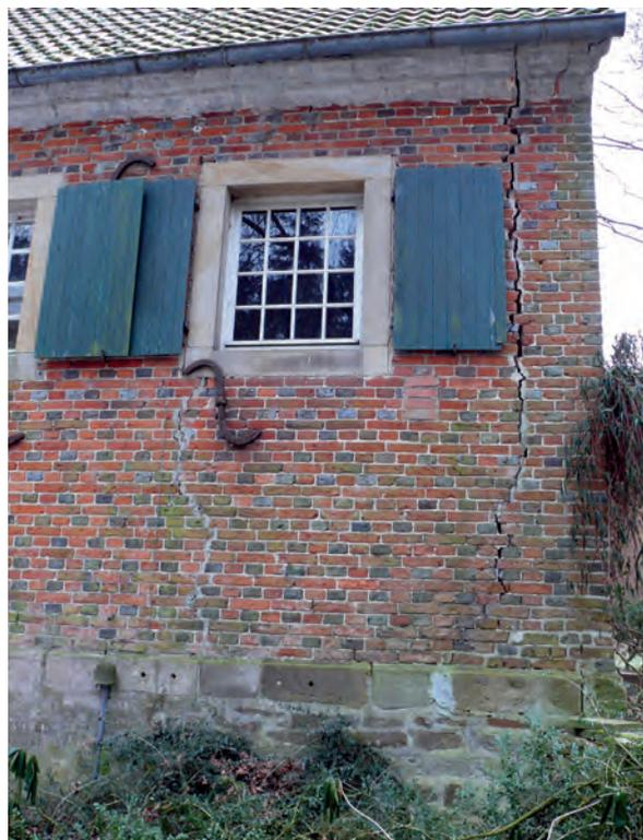
Abb. 5: Vertikalriss in der Westwand
