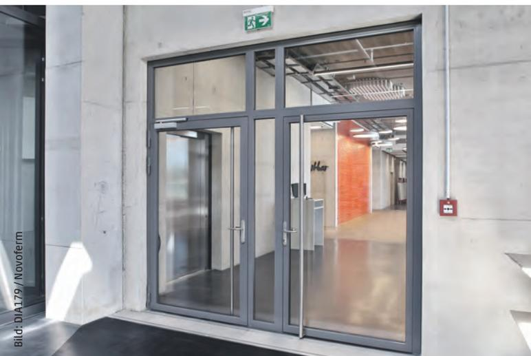
Abb. 2: Großflächig verglaste Türeneanlage mit filigranen Stahlprofilen, bestehend aus zwei gegenläufigen Türflügeln (einwärts und auswärts öffnend).
