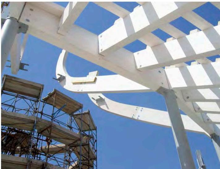
3 Die Mittelstützen nehmen die durchlaufenden Bogenbinder auf sowie die Querträger, an die ein Teil der Binder biegesteif anschließt und hier endet.
