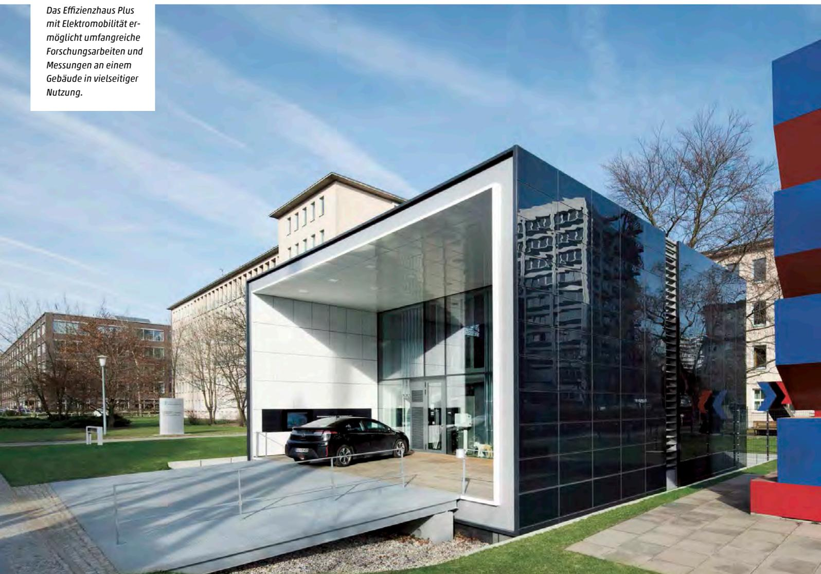
Ein Effizienzhaus Plus weist einen negativen Jahres-primärenergiebedarf und einen negativen Jahresendenergiebedarf auf. Daher sind diesen Gebäuden neben einer hochdämmenden Gebäudehülle und einer hoch energieeffizienten Haustechnik eigene regenerative Energiequellen im und am Gebäude zugeordnet. Die über den Energiebedarf des Gebäudes hinausgehenden Energiegewinne werden zum Beispiel in örtliche Energienetze eingespeist.
