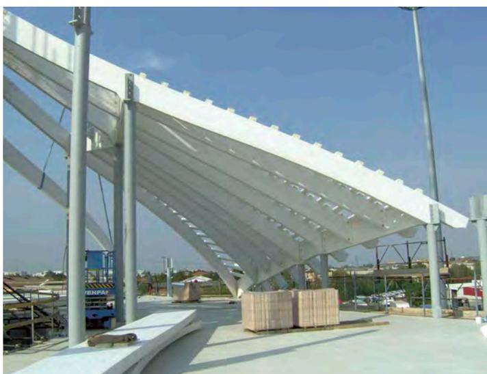
4 Jeder Binder hat eine andere Bogenform, Länge und Dimensionierung. Auch die Höhe der Außen- und Innenstützen variiert rundum.
