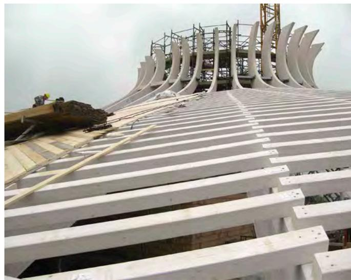
6 Die Querbalken sind feldweise versetzt angeordnet und über die Bindermitte hinaus aufgelegt. Links im Bild: Die Diagonalschalung.
