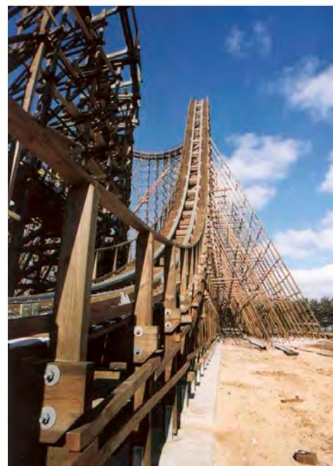
← 3 Seitliche Abstreben stützen die Fachwerke von Colossos auf unterschiedlicher Höhe ab. Fachwerke und Abstreben erhielten jeweils Einzelfundamente. Fußanker und Grundplatte nehmen die Stützenquerschnitte auf.
