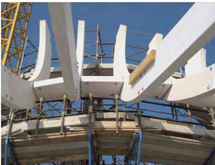
5 Zweiteilige BS-Holz-Querträger liegen wie Schotts zwischen den sich aufwölbenden Bogenbindern und bilden einen Druckring zur Aufnahme der Stützkräfte.
