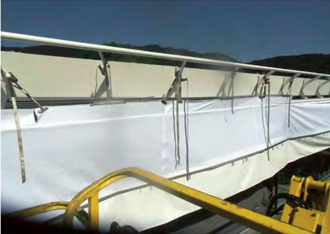
3 Spannen der Membran-Unterseite mittels Hilfskeder
