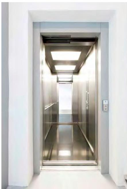
*Der frequenzgeregelte Aufzug verfügt über eine Energierückgewinnung. Der Antrieb ist maschinenraumlos und fast alle Stockwerke werden über Kartenleser verschlüsselt angefahren.*
