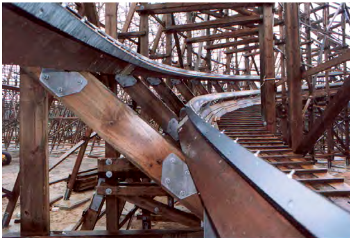
4 Auf den sogenannten „Ledgern“ wurden die Schienenkörper über spezielle Stahlschuhe montiert. Die Schienenverwindungen sind auf der 1500 m langen Strecke überall unterschiedlich ...
