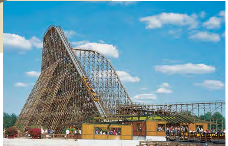
↑ 2 Colossos ist mit bis zu 60 m die höchste und mit 120 km/h auch die schnellste Holzachterbahn in Europa. Ihre Konstruktion ist prototypisch für viele Nachfolgebahnen, wobei Details optimiert wurden, wenn neue Techniken Verbesserungsmöglichkeiten boten.
