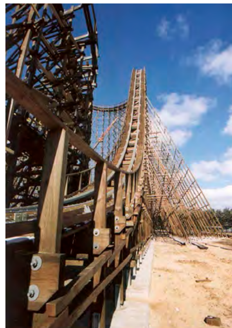
↑ 2 Colossos ist mit bis zu 60 m die höchste und mit 120 km/h auch die schnellste Holzachterbahn in Europa. Ihre Konstruktion ist prototypisch für viele Nachfolgebahnen, wobei Details optimiert wurden, wenn neue Techniken Verbesserungsmöglichkeiten boten.
