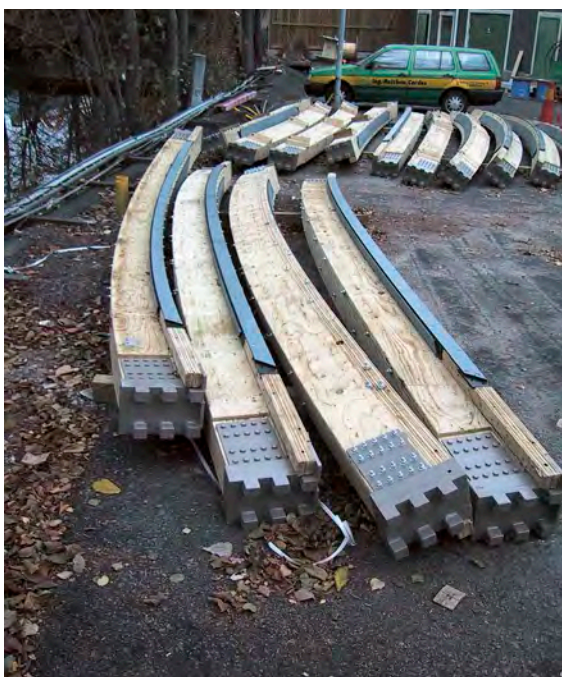
4 Auf den sogenannten „Ledgern“ wurden die Schienenkörper über spezielle Stahlschuhe montiert. Die Schienenverwindungen sind auf der 1500 m langen Strecke überall unterschiedlich ...
