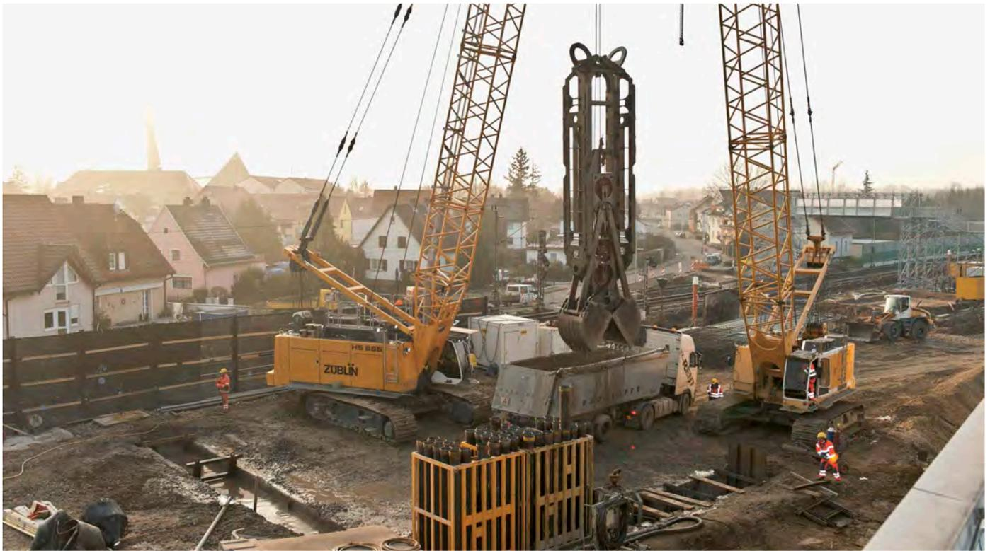
5 Schlitzwandaushub mit Greifer. Der spätere Schlitz ist links im Bild erkennbar.
