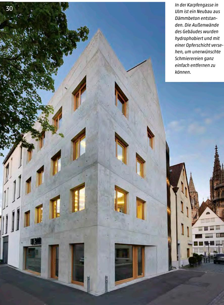
*In der Karpfengasse in Ulm ist ein Neubau aus Dämmbeton entstanden. Die Außenwände des Gebäudes wurden hydrophobiert und mit einer Opferschicht versehen, um unerwünschte Schmierereien ganz einfach entfernen zu können.*
