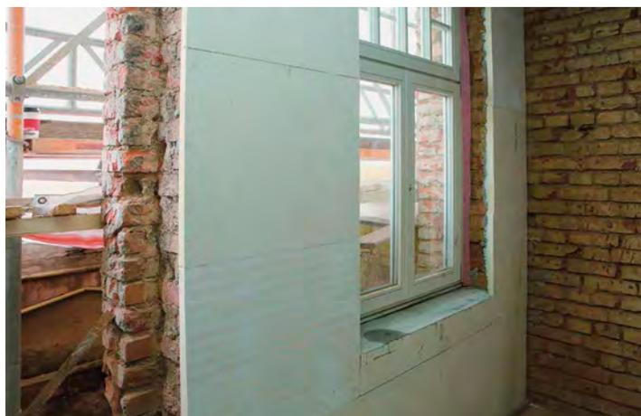
4 Einsatz der Innendämmung für den Erhalt der bestandsgeschützten Fassaden.
