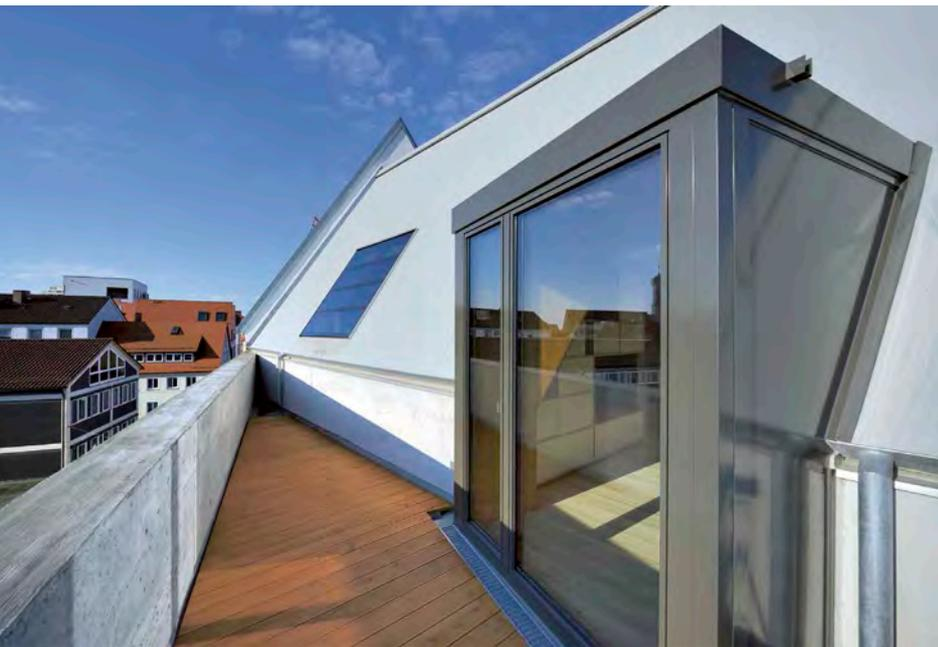
Die Lasten durch ein Dach aus Beton wären zu groß geworden. Deshalb wurde für das Satteldach eine besandete Dachbahn auf einen klassischen Holzdachstuhl montiert.
