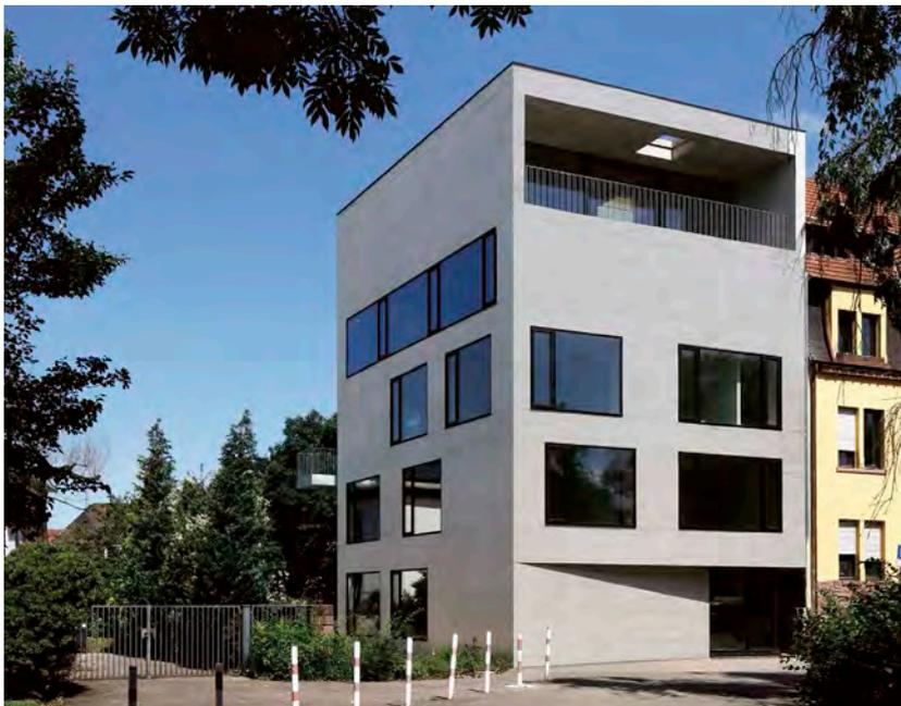
↑ 2 Das Äußere des Gebäudes wurde mittels einer horizontalen Brettschalung betoniert.
