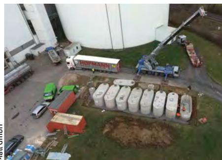
Am Nordzucker-Standort in Wierthe in der Nähe von Braunschweig können acht miteinander verbundene Ovalbehälter einen Löschwasservorrat von 220 m<sup>3</sup> aufnehmen.
