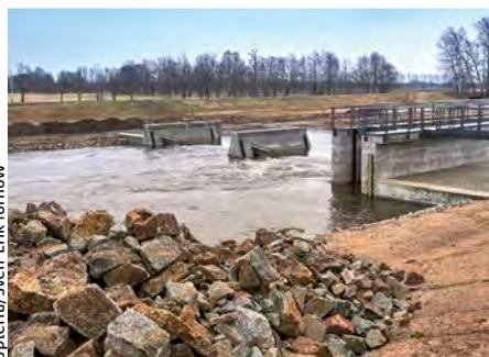
Der Spezialzement „Optablu“ minimiert die thermisch bedingte Rissneigung aufgrund seiner niedrigen Hydratationswärmeentwicklung bei massigen Bauteilen wie einem Wehr.
