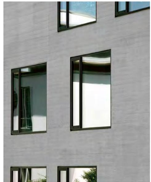
← 1 Das Büro- und Wohngebäude wurde monolithisch aus „Liapor“-Leichtbeton in Sichtbetonoptik realisiert.
