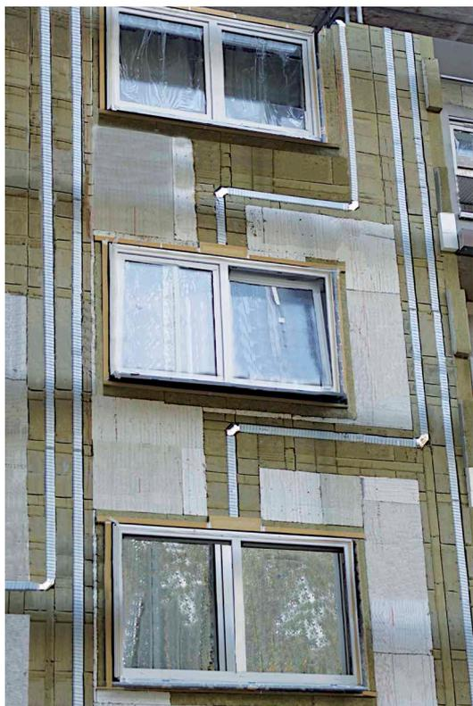
Sanierung der Fassade mit Integration der Zu- und Abluftleitungen in die Außendämmung
