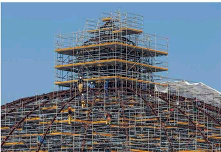
Die abgetreppt montierten Arbeitsebenen auf Basis des „Peri-Up-Flex“-Modulgerüstsystems passen sich räumlich an die vorhandene, zu konservierende Stahlkuppelkonstruktion an.
