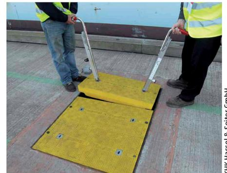
Einfaches Anheben der Faserverbundabdeckungen durch spezielle Aushebeschlüssel
