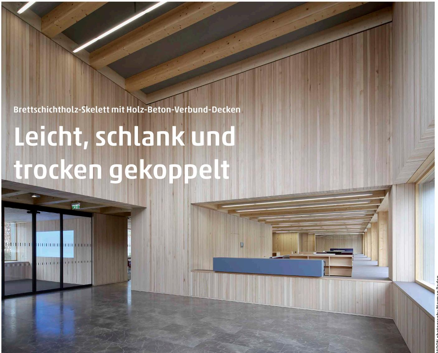
Brettschichtholz-Skelett mit Holz-Beton-Verbund-Decken
