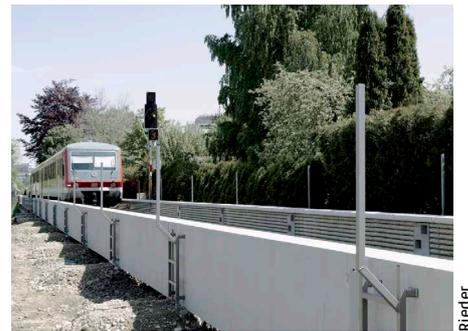
Die Montage der Lärmschutzwände entlang der 1,6 km langen Strecke für das Pilotprojekt in Burghausen dauerte nur 18 Stunden.
