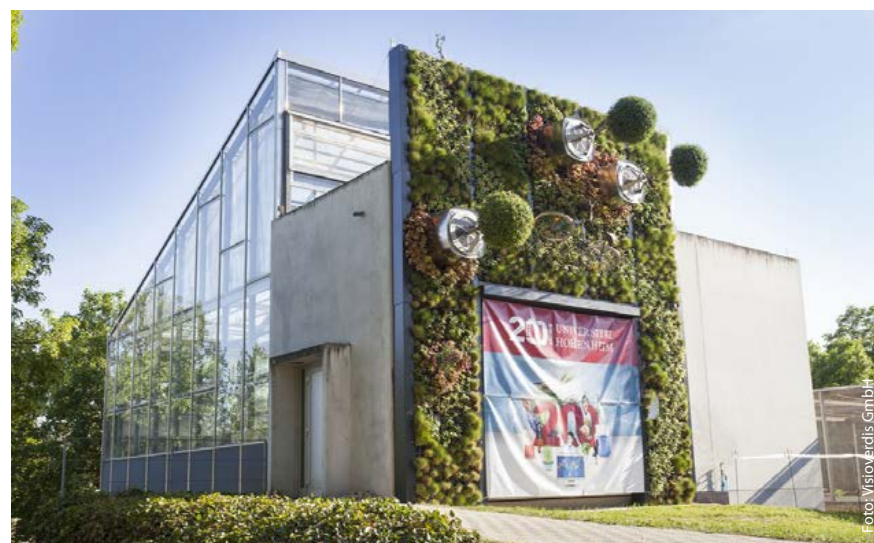
Der vertikale Garten in Hohenheim ist mit drei GraviPlants bestückt, die so eine Begrünung von bis zu zwei Meter vor der Fassade ermöglichen.
